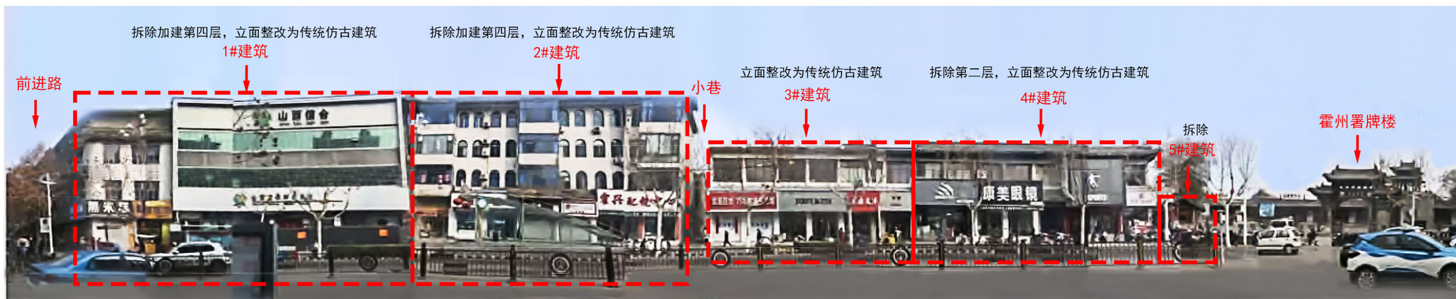
鼓楼东街北侧、霍州署西侧沿街建筑现状照片
