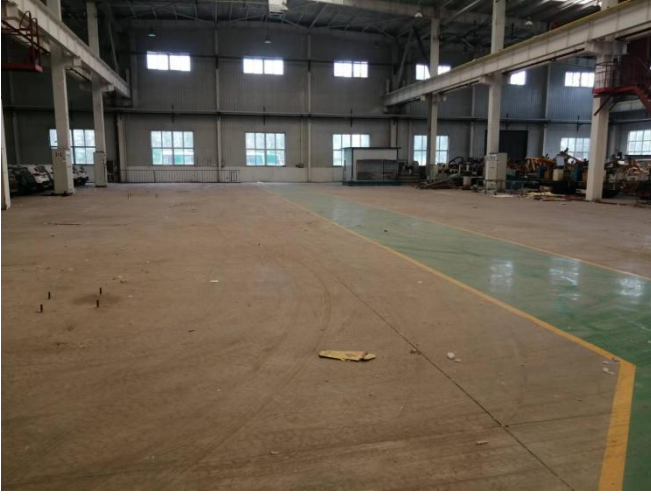
本次项目危废暂存库利旧 3#厂房内部现状
