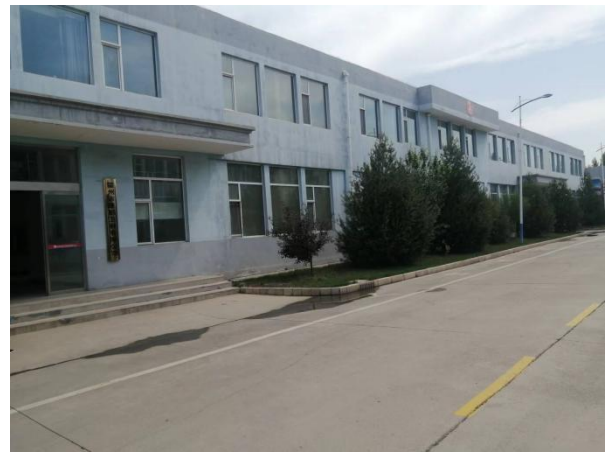
本次项目办公区利旧 3#厂房生产辅房
