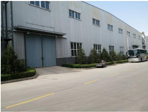
本次项目利旧 3#厂房主主体厂房
